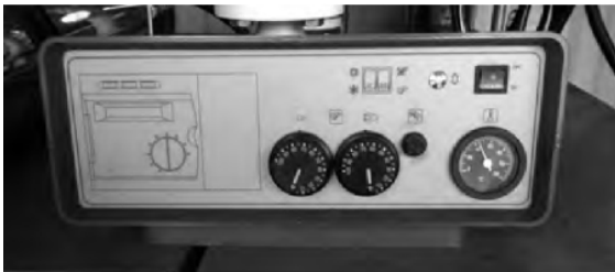
Fig. 3 Pannello di controllo del circuito primario della caldaia.
