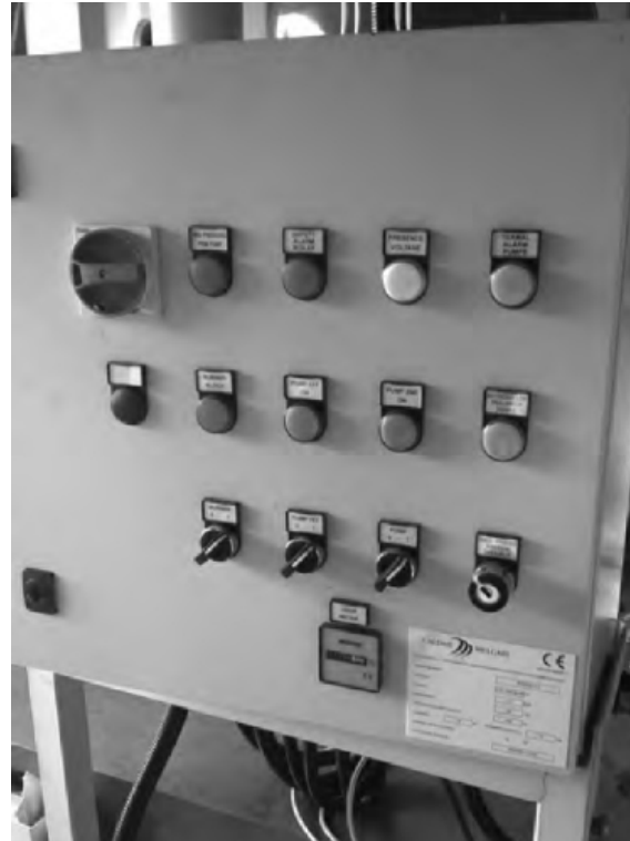
Fig. 4 Esempio di pannello di controllo della centralina di distribuzione.
