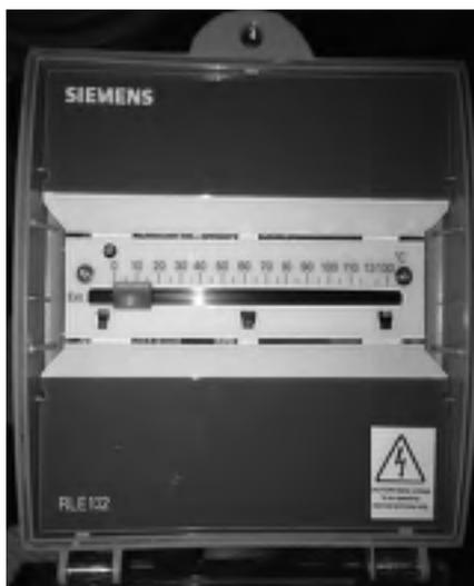
Fig. 4 - Pannello di controllo primario della caldaia
