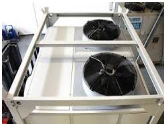
In condizioni di funzionamento normali, la temperatura di mandata viene visualizzata sul display. Il motore della ventola situata in cima all'unità funzionerà solamente quando deve rimuovere il calore dalla serpentina di condensazione.
