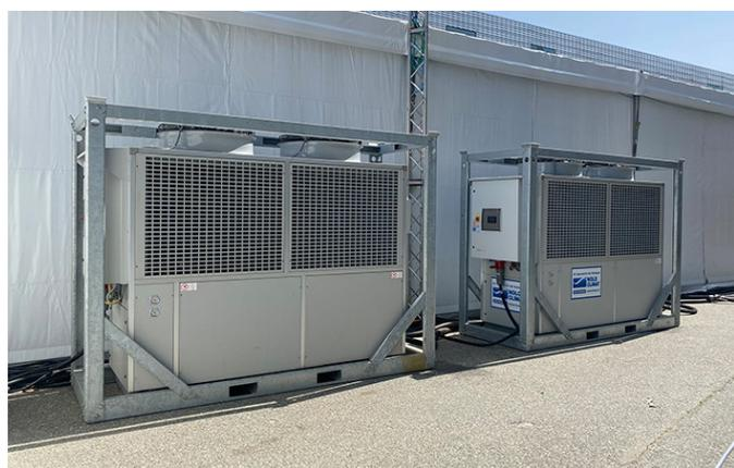
L'utilizzo di **UNITÀ DI TRATTAMENTO ARIA** permette la diffusione dell'aria condizionata e del riscaldamento in zone specifiche. A seconda del modello possono essere installate all'esterno o all'interno del locale da climatizzare, offrendosi come alternativa ai condizionatori portatili.
