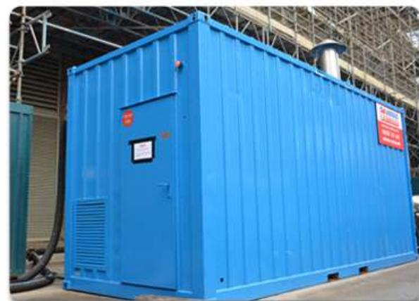
Potenza di riscaldamento 1500 kW
